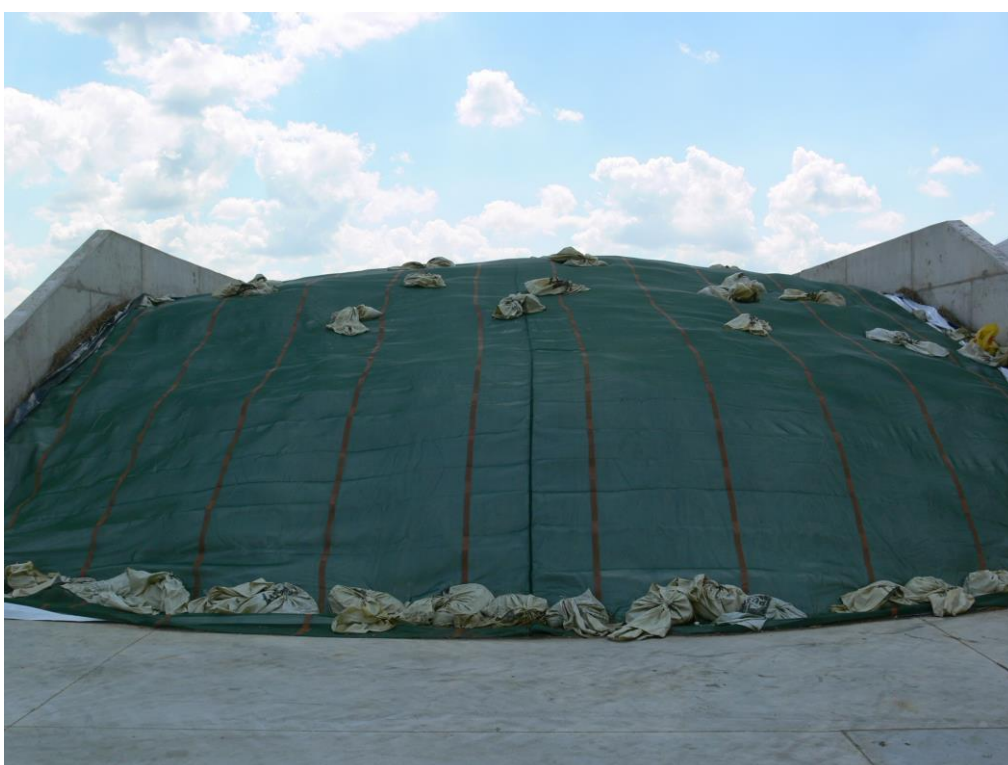
Fotografia 6. Sposób przykrycia kieszonki w silosie przejazdowym (fot. W. Wardal)
