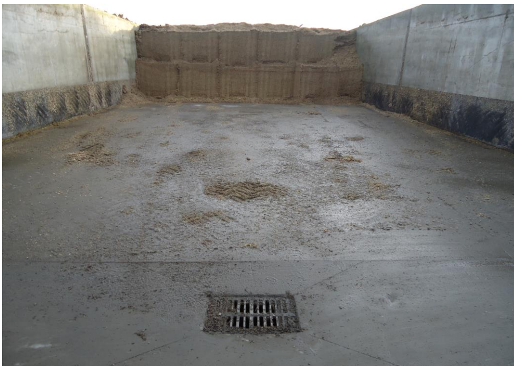
Fotografia 5. Wykonanie spadków płyty dennej silosu przejazdowego w celu odprowadzenia nadmiaru odcieków oraz wody opadowej (fot. W. Wardal)
