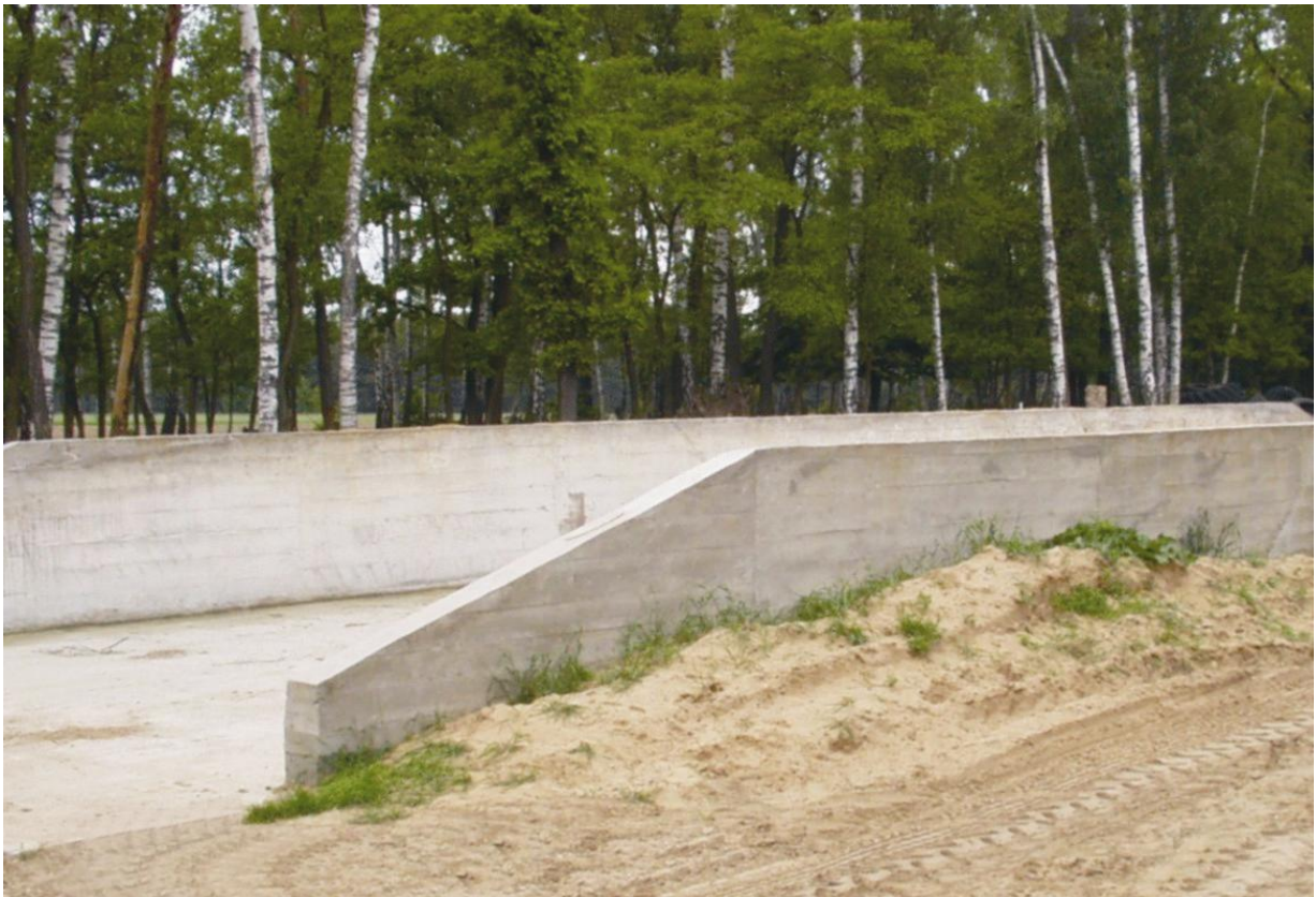
Fotografia 4. Silos przejazdowy bezpośrednio po wybudowaniu (fot. ITP)
